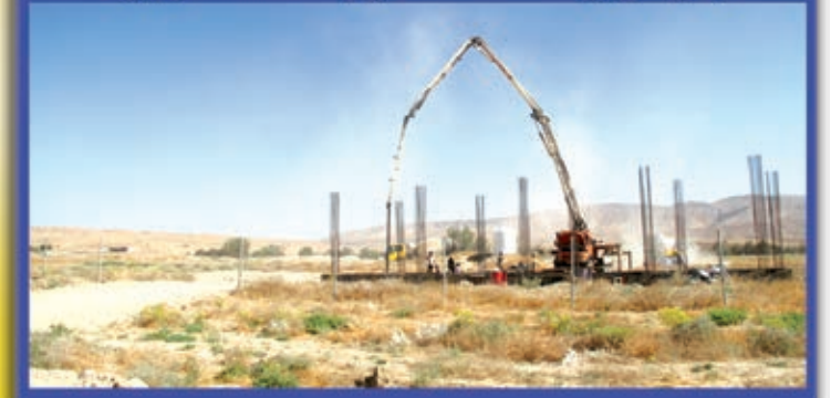
بتون ریزی اسکلت پایانه مسافربری
