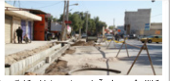
کانال قدیم دفع آبهای سطحی خیابان کارگر دیگر جوانکو نیست کانال جدید با پیشرفت ۴۰ درصد در حال اجراست
