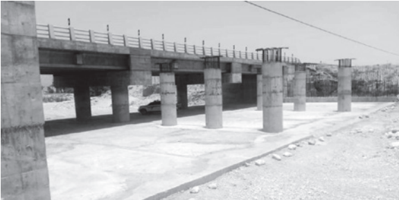
تعمیرات پل بزرگ بست فاریاب در ۱۸ محور لار - بندرعباس که عملیات اجرایی آن طی ۴۰ روز با مشخصات سه دهانه ۱۵ متری و مجموع ۴۵ متر با ارتفاع ۸ متر در
