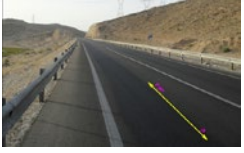
پروژه احداث باند دوم جهرم-لار-بندرعباس از نظر اعتباری ضعیف است
