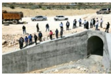
آغاز ساخت چهار دستگاه پل در محورهای روستایی خنج
