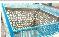
احداث ۳۰ ذخیره گاه آب در ارتفاعات هرم
